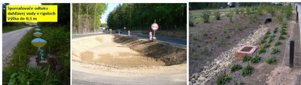
Obrázok 26 - Schéma infiltračnej priekopy pozdĺž cesty, príklady aplikácie a zbierania dažďovej vody v rigoloch (USA, Rakúsko)
