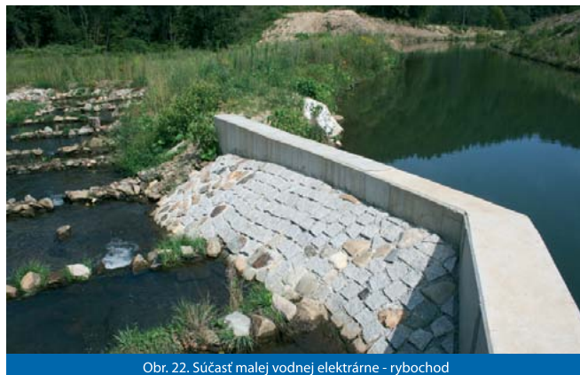
Obr. 22. Súčasť malej vodnej elektrárne - rybochod
