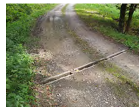
Odvodňovanie lesnej a poľnej cesty
