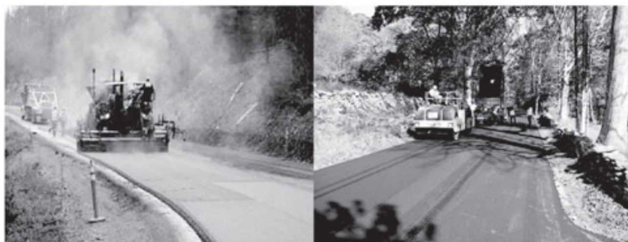
Obrázok 2 Pokládka horúcej (v ľavo) a nízkotepelnej (v pravo) asfaltovej zmesi
