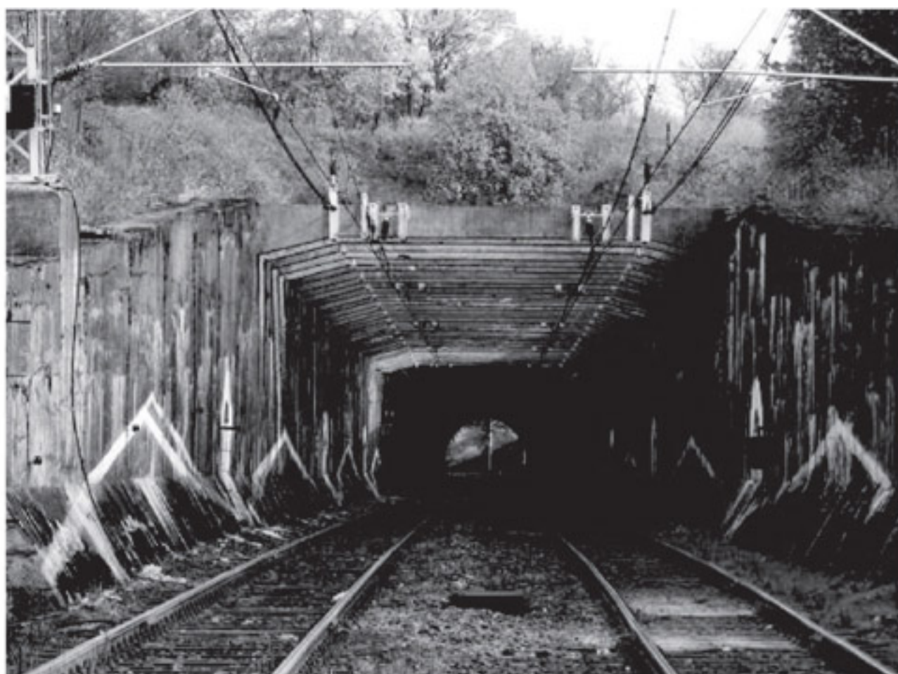
Obrázek 2 Pohled na žebra zárubních zdí ze zastávky Střelná směrem do tunelu
