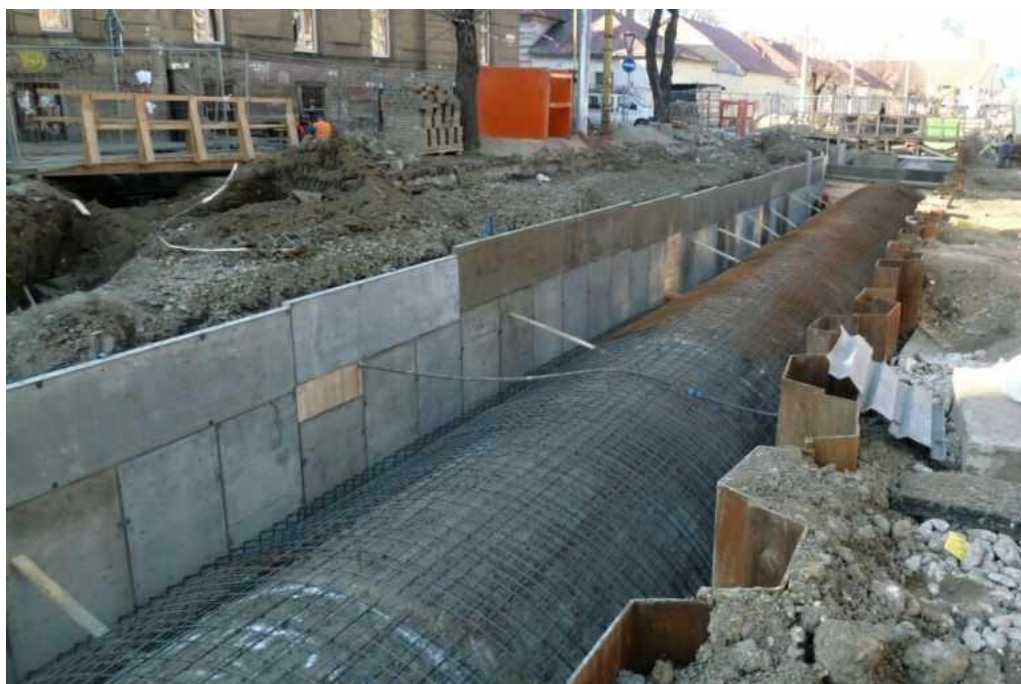
Obrázek 3 připravená ocelová výztuž pro korytnačku
