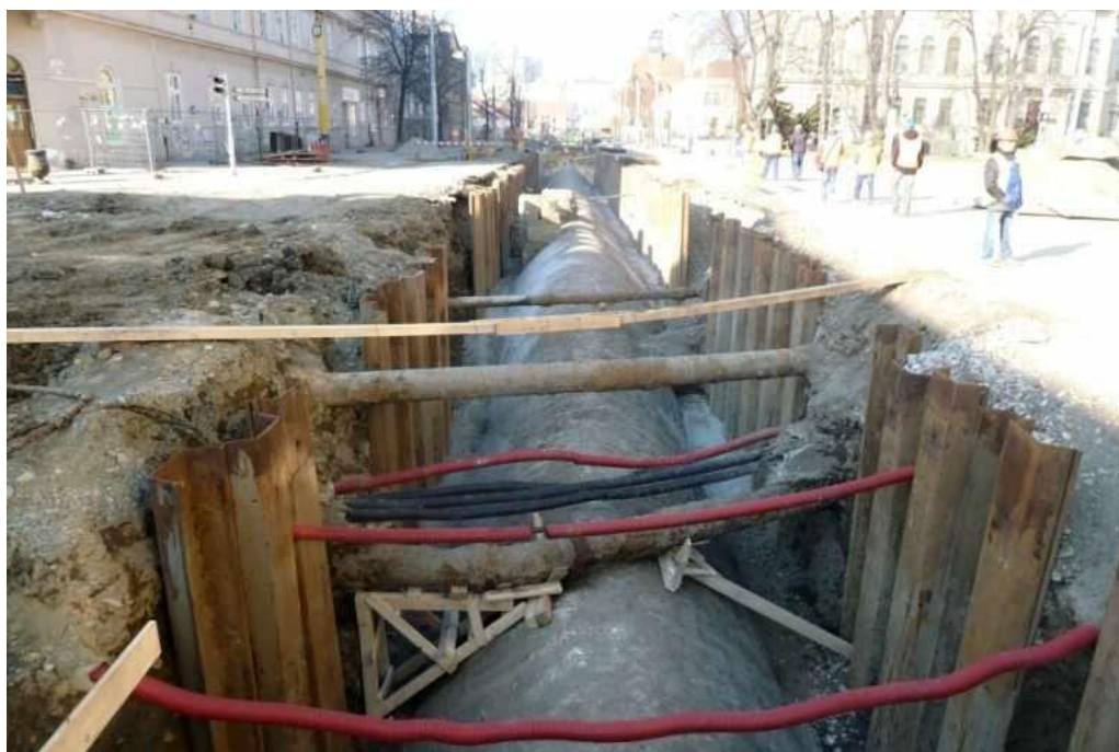
Obrázek 2 Odhalená kanalizace DN 2200 ul. Hviezdoslavova
