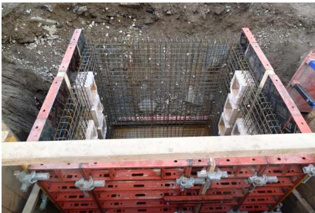
Obrázek 4 připravená ocelová výztuž pro šachtu kabelovodu
