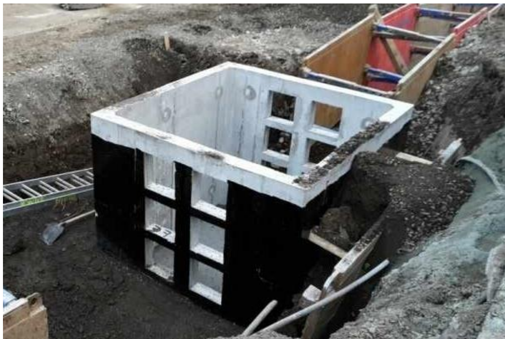
Obrázek 5 hotové stěny šachty kabelovodu s otvory pro 6 multikanálů
