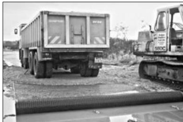
b) vystužené podkladové vrstvy pod dočasnou komunikáciou
