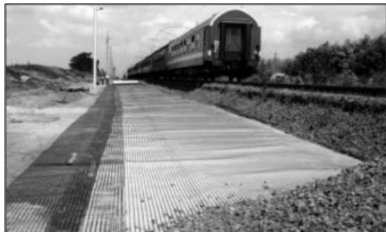
a) vystužené konštrukčné vrstvy podvalového podložia
